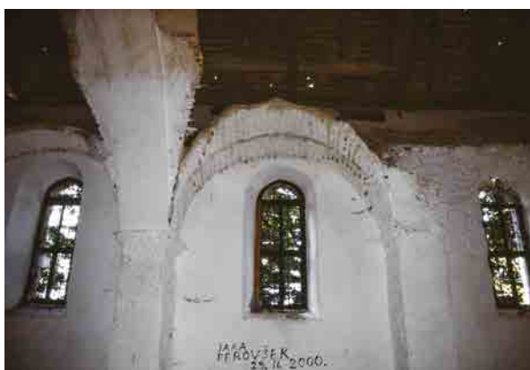
↑ Zahodna stena v notranjščini ortneške grajske cerkve z ostanki ometane lesene obočne konstrukcije v ladji leta 2002 (Igor Sapač).
