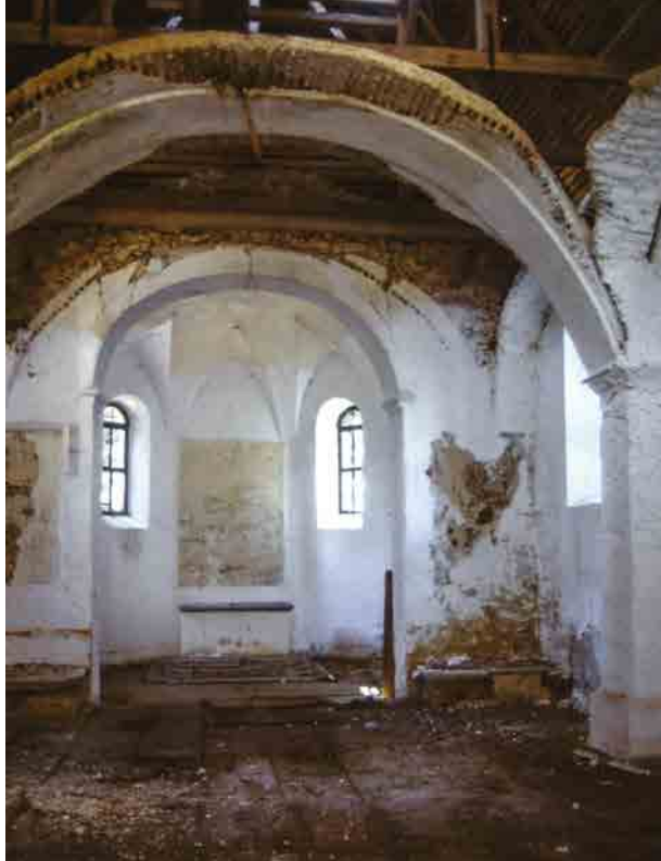
↑ Notranjščina ortneške grajske cerkve z ostanki ometane lesene obočne konstrukcije v ladji leta 2002 (Igor Sapač).
