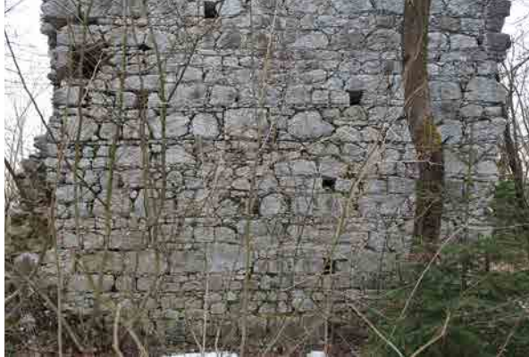
↑ Struktura kamnite zidave v spodnjem delu zunanje strani visokega ostanka severovzhodne fasadne stene glavnega poslopja gradu Breg (Igor Sapač, 2018).
